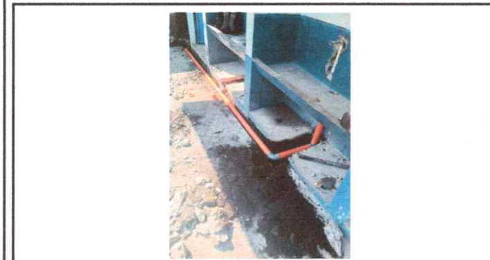
Foto 7: Sustitución de mezcladora lavamanos (contra llave, tubo de abasto, Conectores)
