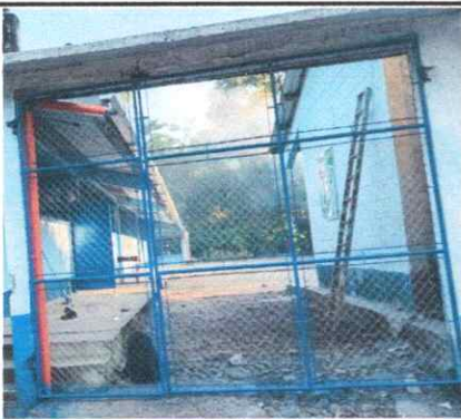
Foto 17: Fabricación e Instalación de porton de metal de ingreso
