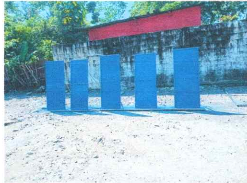
Foto 16: Fabricación e Instalación de puerta de metal individual en BAÑO
