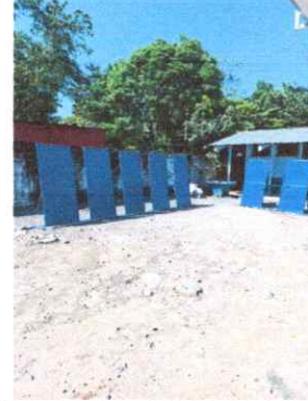
Foto 14: Fabricación e Instalación de puerta de metal en AULA
