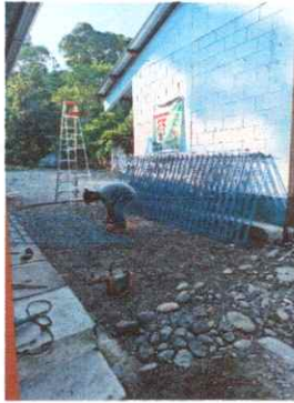
Foto 13 Fabricación e instalación de balcones de hierro en ventana
