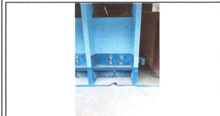
Foto 9: Sustitucion de grifos
