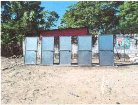
Foto 15: Fabricación e Instalación de puerta de metal PRINCIPAL en BAÑOS
