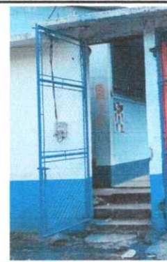
Foto 18: Fabricación e Instalación de puerta de metal de ingreso
