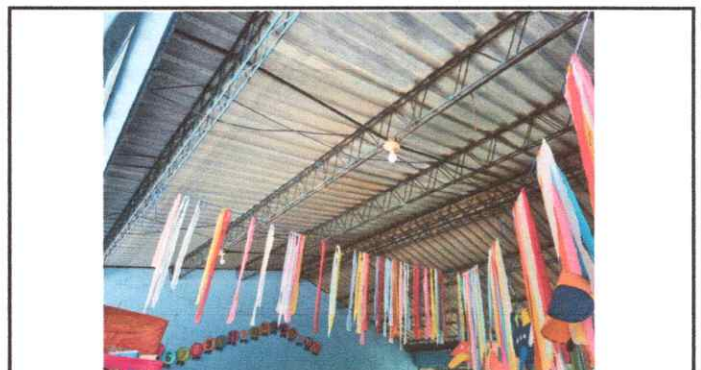
Foto 12: Sustitución de focos ahorradores
