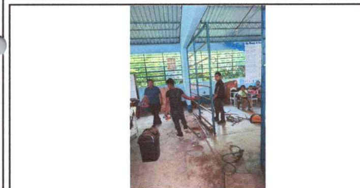
Foto 11: 9.1. Mantenimiento a portones de metal ENTRE AULAS
