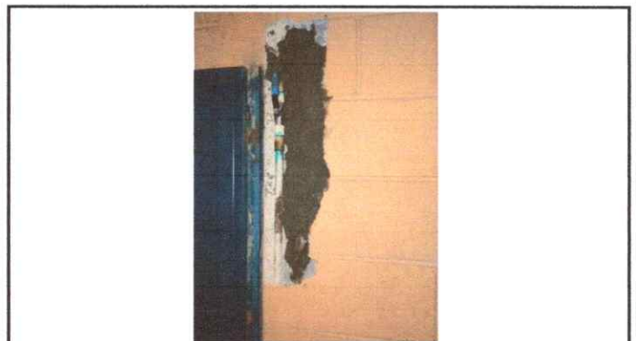
Foto 10. Sustitución de llave de paso
